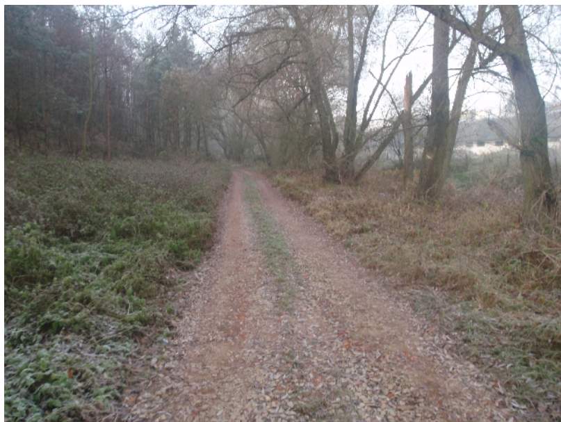
obr.4 – 1.ČÁST – stávající cesta částečně zpevněná štěrkem minimální podélné sklony
