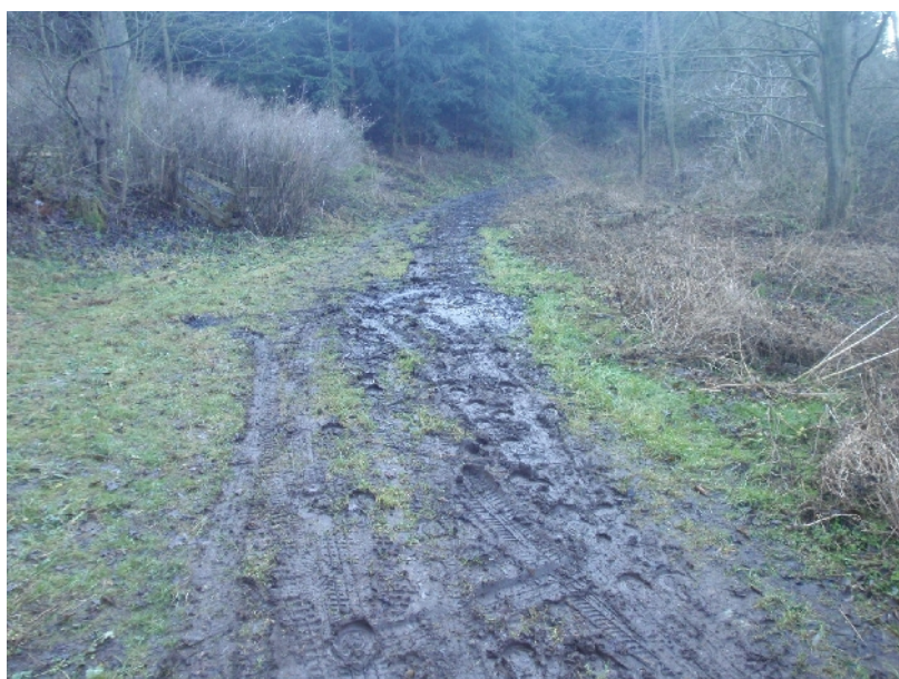
obr.8 – 1.ČÁST – km1,000 – podmáčená konstrukce – zlepšení podloží+geotextilie
