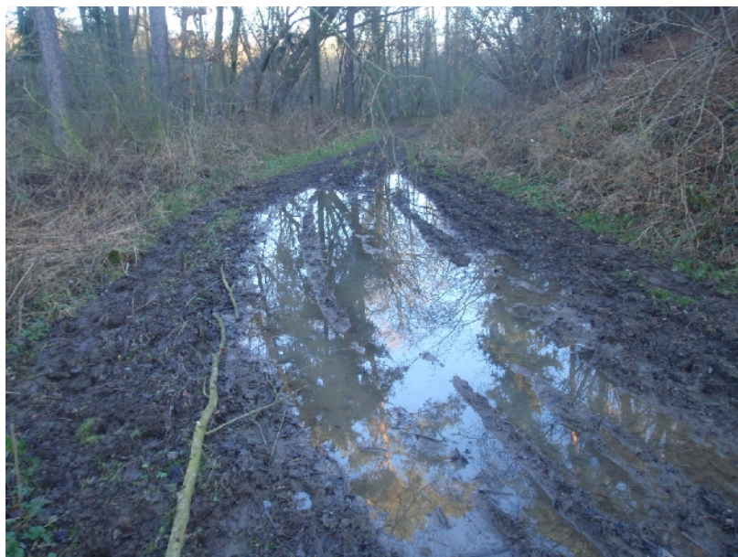
obr.10 – 1.ČÁST – km1,350 – rozsáhlá sanace – výměna podloží+drenáže (pohled proti směru staničení)
